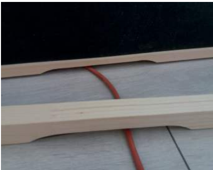
Abb. 34: Einsetzen der Aussteifungsleiste für IR-Wärmeplatten VitaMy
