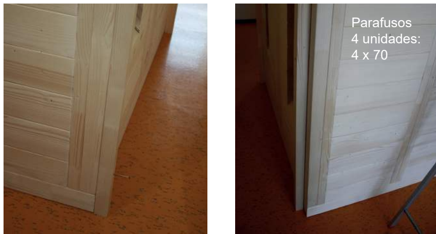
Fig. 48: Montagem das barras distanciadoras na parede traseira
