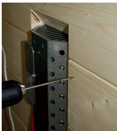
Fig. 38 : Monter le cache du radiateur arrière
