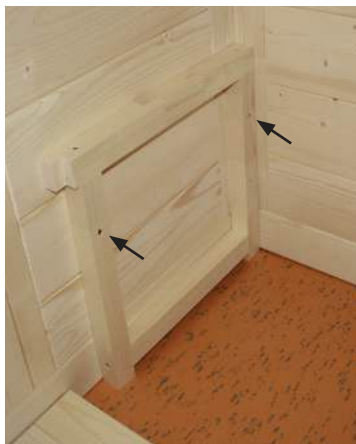
Fig. 31 : Montage du support du banc
