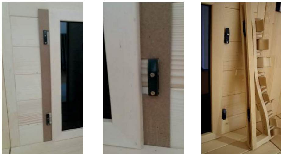
Fig. 50: Montagem dos encostos
