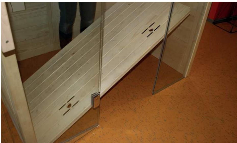
Fig. 28: Inserir o chão da cabina
