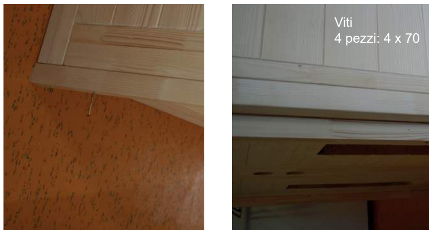
Fig. 47: Montaggio dei listelli distanziatori sul pannello posteriore
