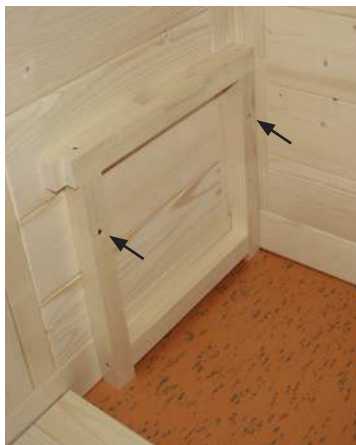
Fig. 32: Montagem do apoio do banco
