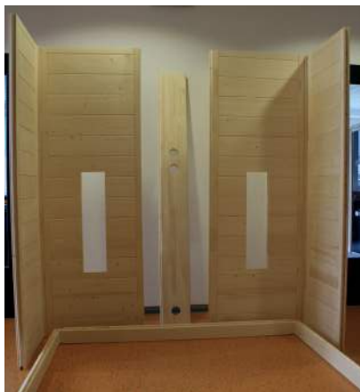
Fig. 5: Montagem na armação do chão
