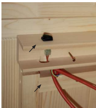
Fig. 32: Montaggio dei listelli a U per i pannelli radianti
