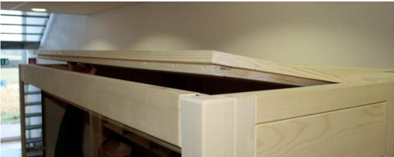
Abb. 18: Einlegen Dachelemente vorne
