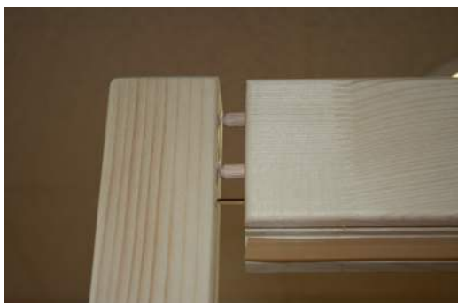
Fig. 13: Montagem da barra maciça por cima da porta envidraçada
