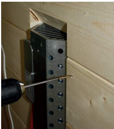
Abb. 38: Blende der Rückenstrahler montieren
