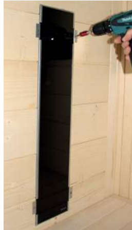
Abb. 37: Rückenstrahler (Infrarot-Strahler ECO 350) montieren
