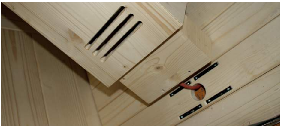
Abb. 28: Frontstrahler fixieren
