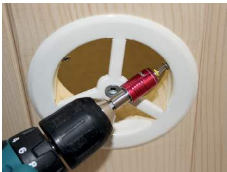
Fig. 35: Montaggio della ventilazione
