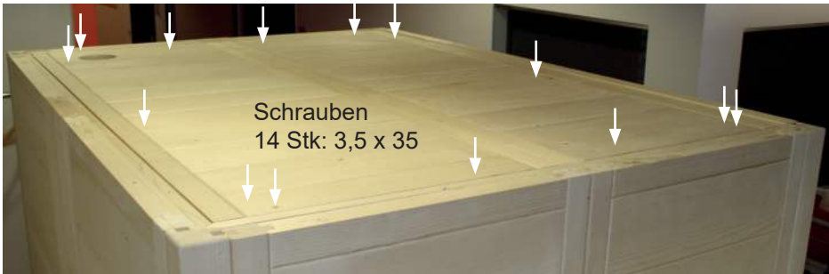
Abb. 19: Befestigen der Dachelemente
