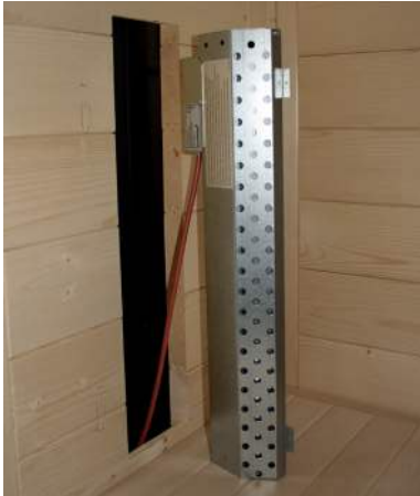
Abb. 37: Rückenstrahler (Infrarot-Strahler ECO 350) montieren
