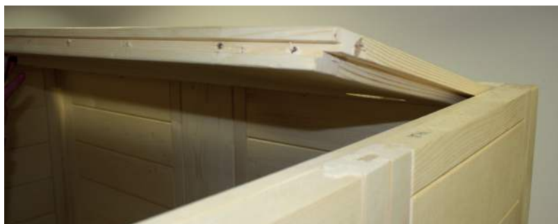
Fig. 18: Inserção dos elementos de teto da frente
