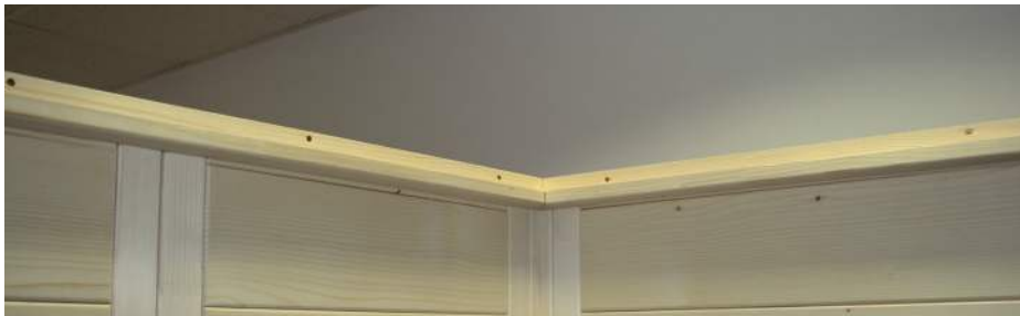
Afb. 17: Plaatsen van dakelement achter met ventilatoruitsparing
