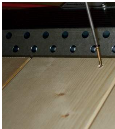
Fig. 38: Montaggio della mascherina degli irradiator posteriori
