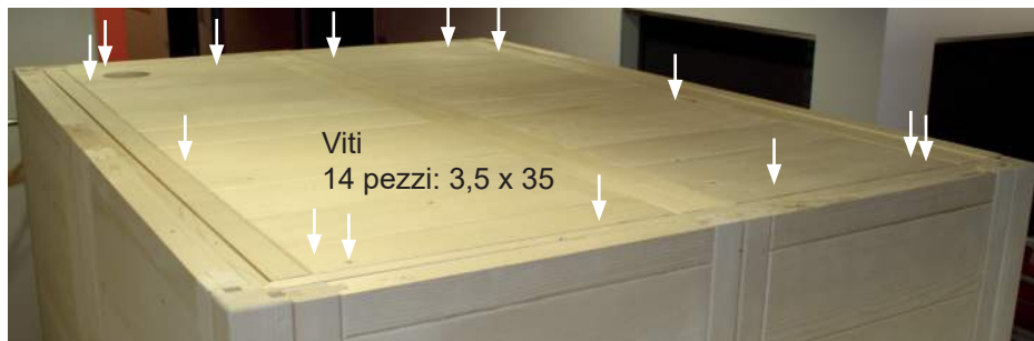
Fig. 19: Fissaggio degli elementi tetto
