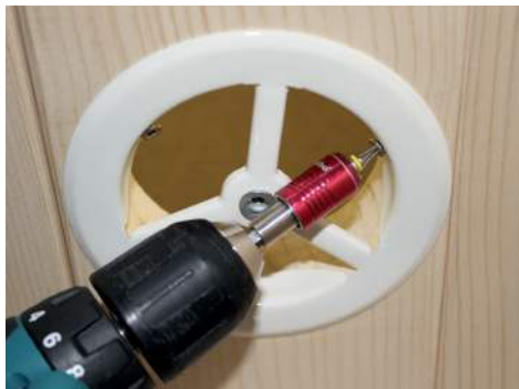
Fig. 36: Montagem da ventilação
