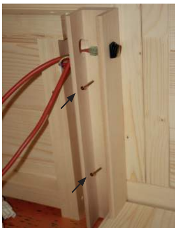
Abb. 32: Montage der U-Leisten für Wärmeplatten
