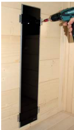
Fig. 37 : Monter le radiateur arrière (radiateur infrarouge ECO 350)
