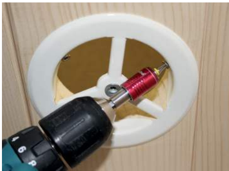
Abb. 35: Montage der Entlüftung
