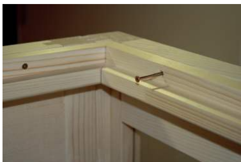
Fig. 15: Montaggio dei listelli di supporto del tetto
