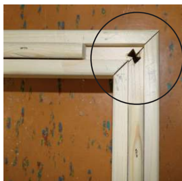
Fig. 2: Unir os elementos do chão
