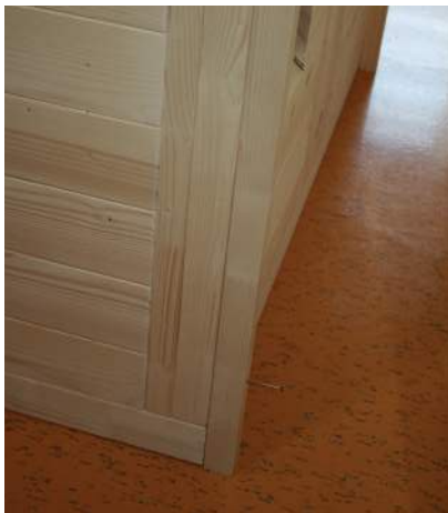
Abb. 47: Montage Abstandleisten Rückwand
