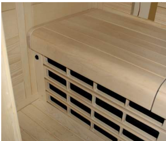
Fig. 36 : Pose du banc
