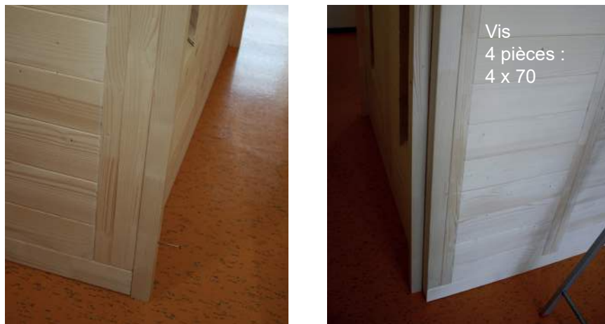
Fig. 47 : Montage des barres d'écartement paroi arrière
