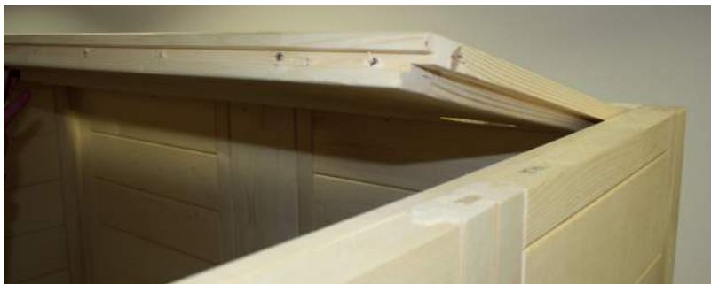
Afb. 18: Plaatsen van dakelementen voorzijde
