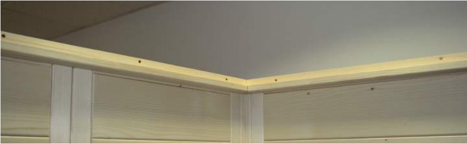
Abb. 17: Einlegen Dachelement hinten mit Lüfterausschnitt
