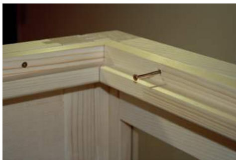
Fig. 15 : Montage baguettes d'appui de toit
