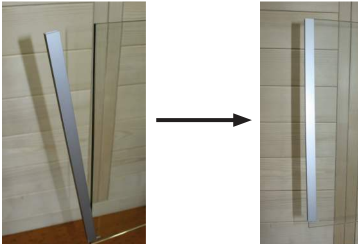
Abb. 11: U-Profile an den Glasplatten anbringen
