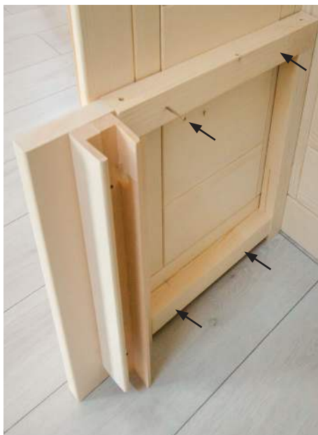
Fig. 18: Montare i supporti della panca
