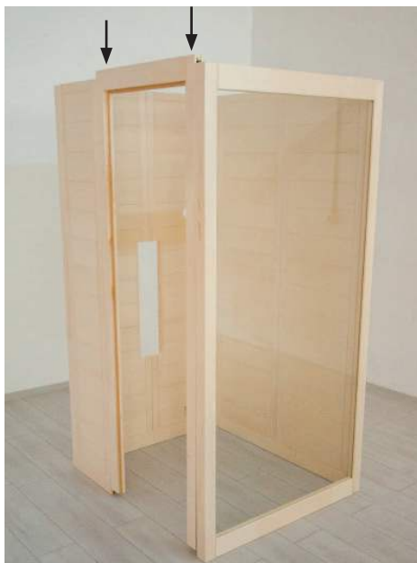
Fig. 10: Installing the door frame
