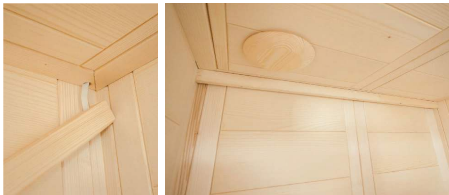
Fig. 24 : Fixer la barre à LED
