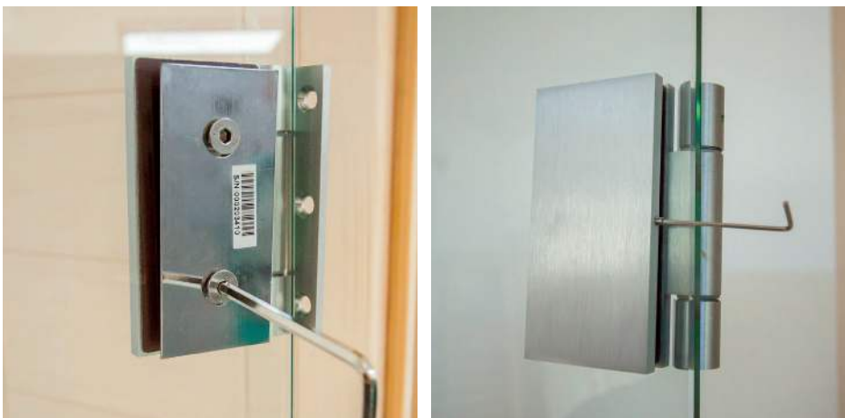
Abb. 32: Montage Türbeschläge 2
