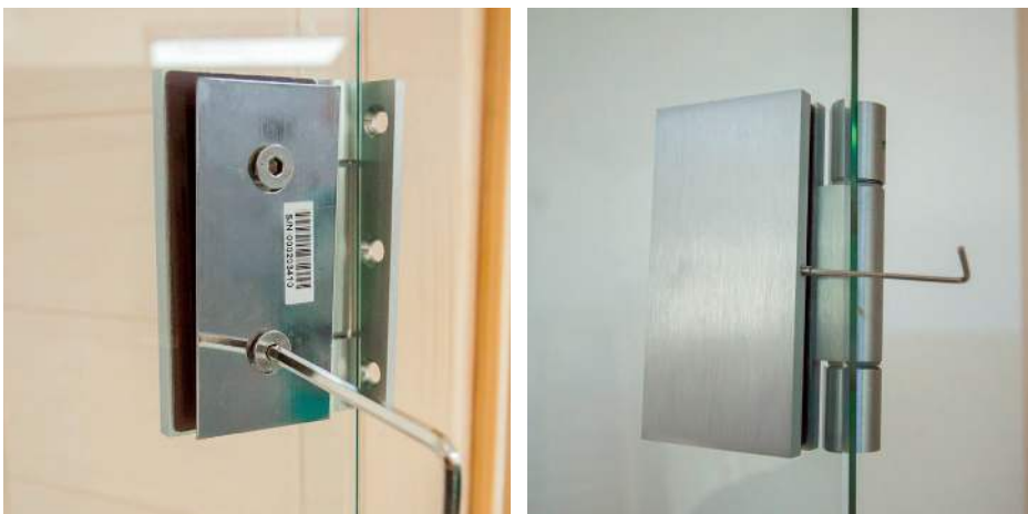
Fig. 32: Montaggio delle cerniere della porta 2
