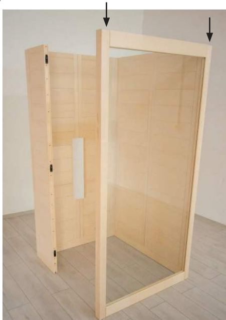
Fig. 10: Installing the door frame
