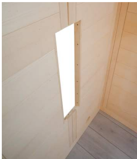
Fig. 6: Inserimento dell'elemento parete con intaglio
