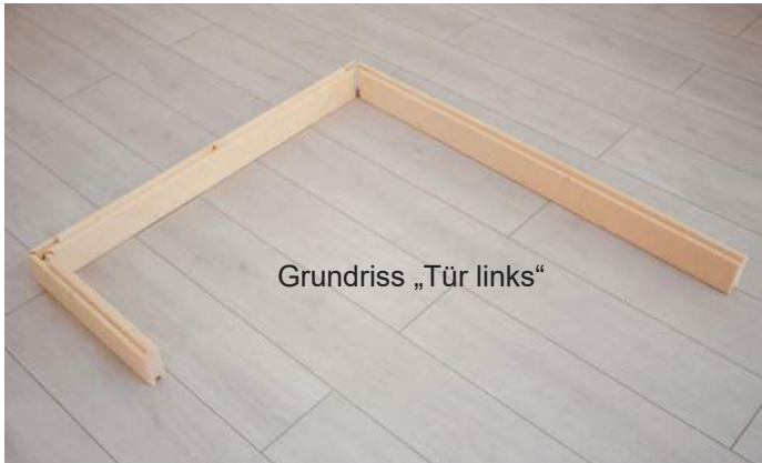
Abb. 1: Auflegen der drei Bodenrahmen-Elemente
