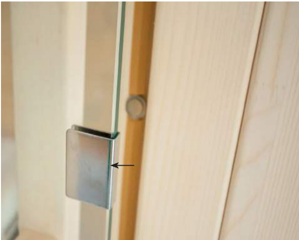
Abb. 35: Montage Überschub-Blech
