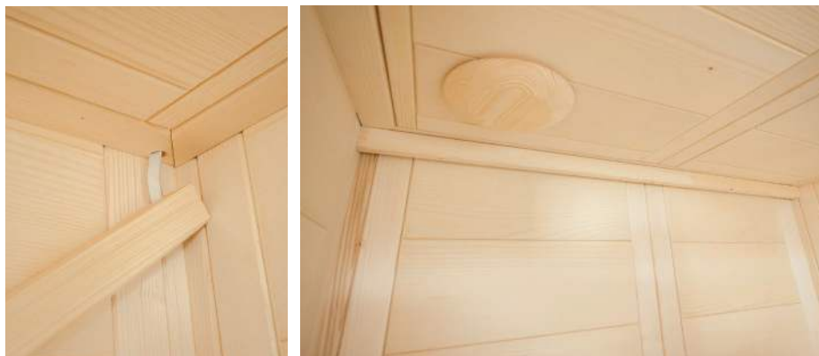
Fig. 24: Fissaggio del listello a LED
