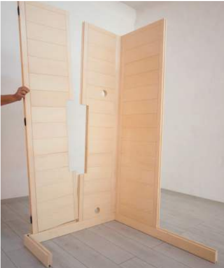
Abb. 6: Wandelement mit Ausschnitt einsetzen
