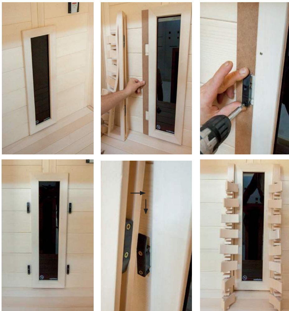
Fig. 29 : Montage des dossiers
