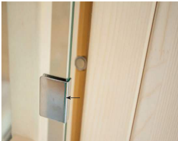
Fig. 35: Montagem da chapa de transferência
