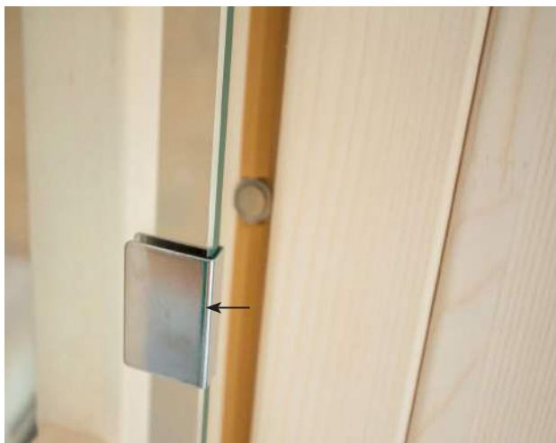
Fig. 35: Montaggio della piastra a scorrimento
