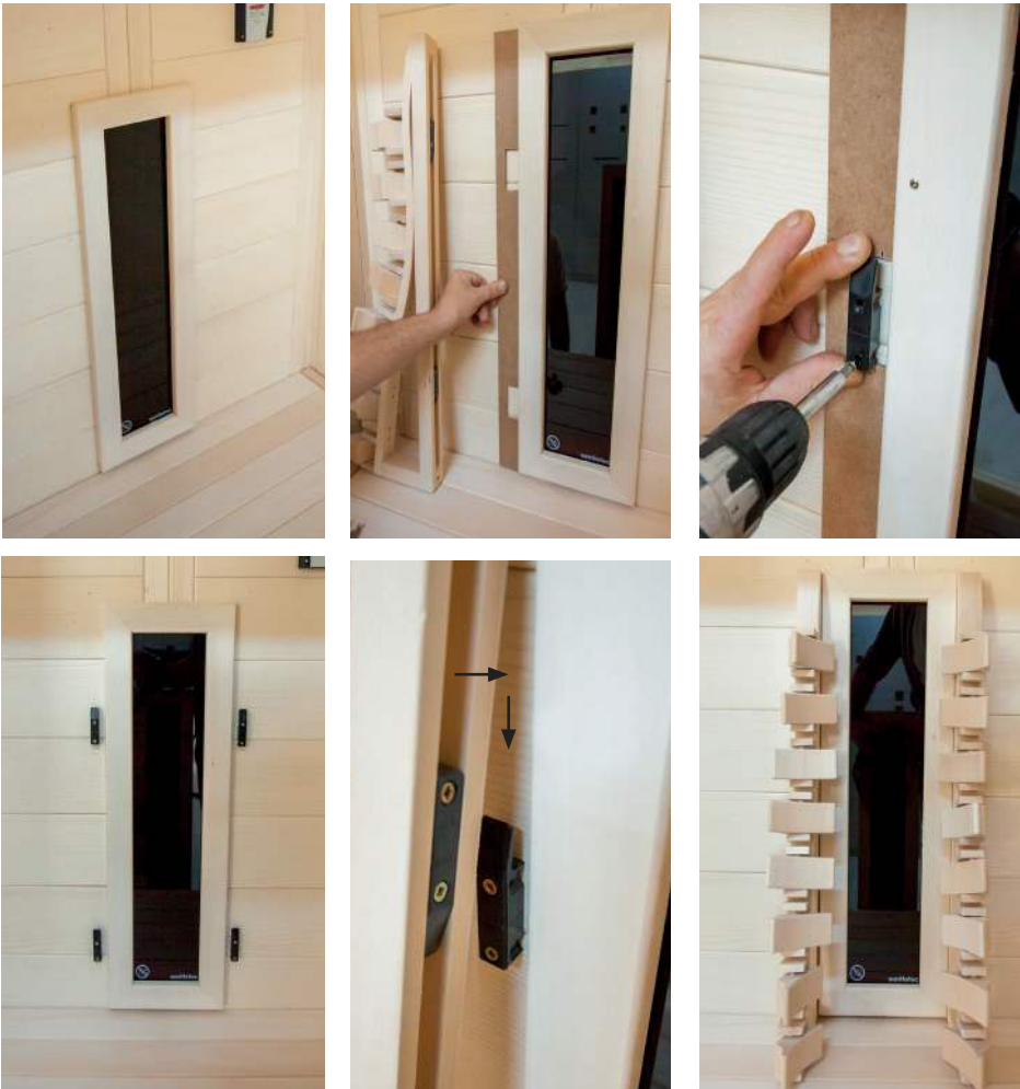
Abb. 29: Montage Rückenlehnen
