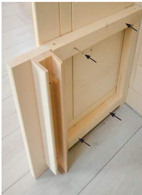
Abb. 18: Bankauflagen montieren
