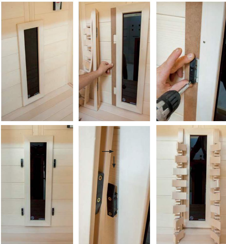
Fig. 29: Montaggio degli schienali
