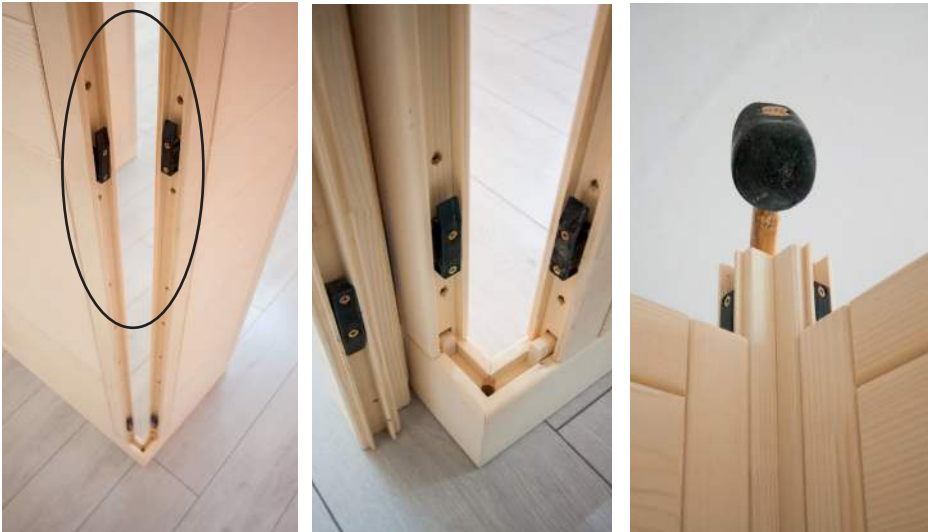
Abb. 4: Wandelemente mit Ecksteher verbinden
