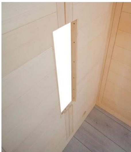
Fig. 6: Instalar o elemento de parede com abertura
