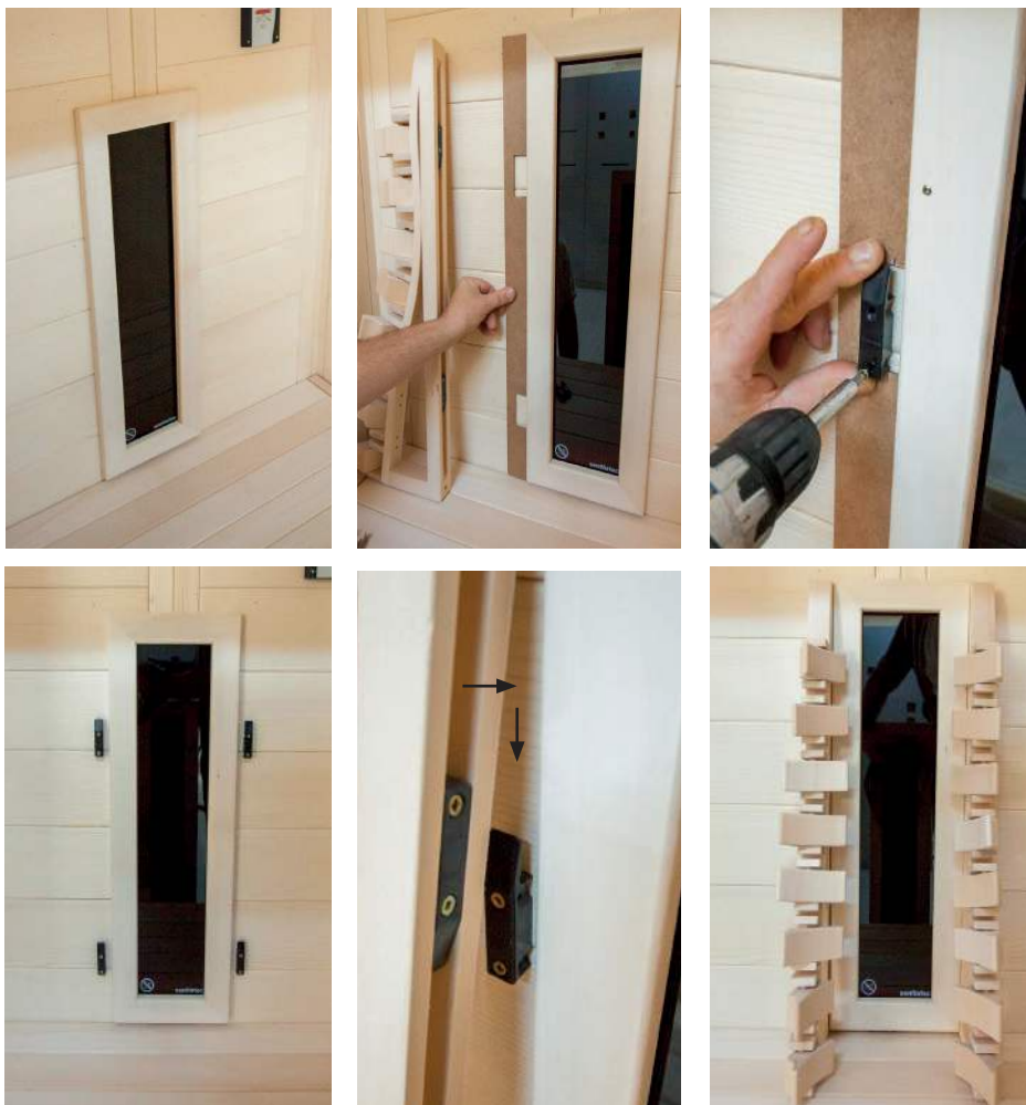
Fig. 29: Montagem dos encostos
