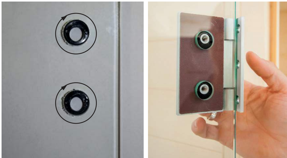
Fig. 31: Installing door fittings 1
