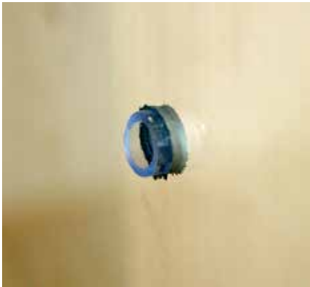
Silikonring in Bohrungen einlegen
