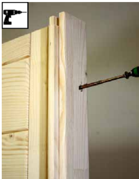
8 vis 6 x 120 mm par montant d'angle
