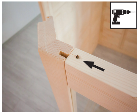
Bohrer 3 mm, 1 Stk. Schrauben 4 x 70 mm
