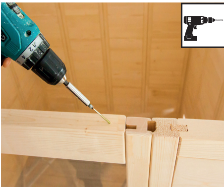
Bohrer 3 mm, 1 Stk. Schrauben 4 x 70 mm
