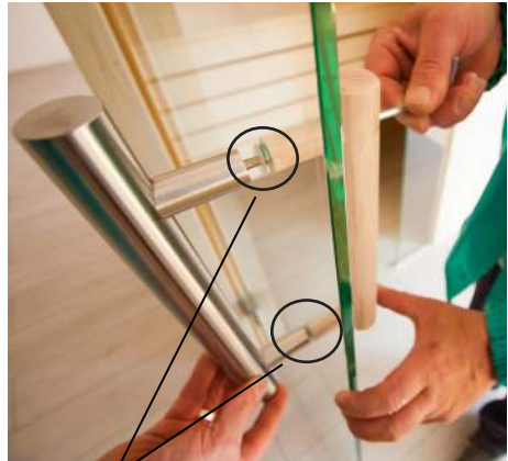
Kunststoff-Beilagscheiben bei Niro-Griff beilegen
