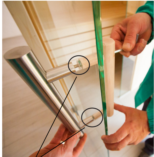
Applicare rondelle di plastica nelle maniglie Nirosta
