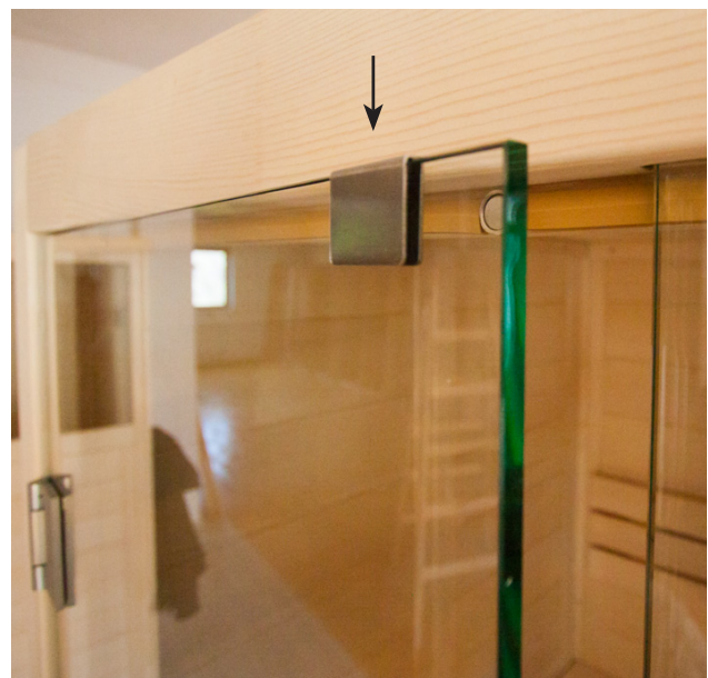
Kunststoff-Beilagscheiben bei Niro-Griff beilegen
