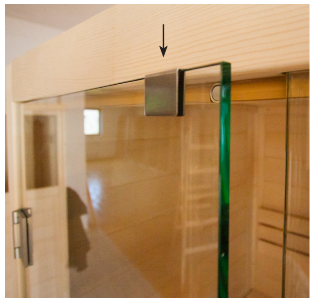
Applicare rondelle di plastica nelle maniglie Nirosta
