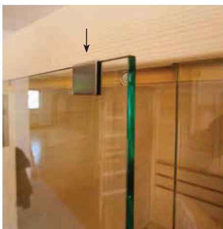
Applicare rondelle di plastica nelle maniglie Nirosta
