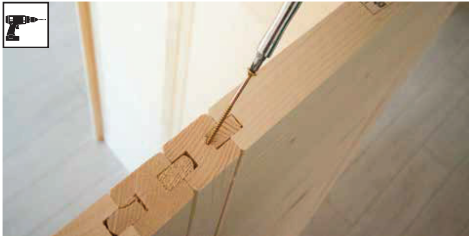
Punta per trapano da 3 mm, 7 viti 4 x 70 mm
